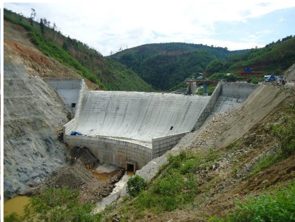
Đập tràn bậc dưới
