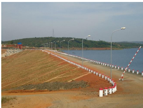
Đập chính bậc trên
